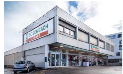
54. Reinach AG, Hauptstrasse 45
