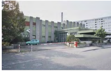
17. Delémont, Rue de l'Avenir 1
