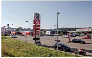
32. Hinwil, Wässeristr. 18/20/24a/24b/26
