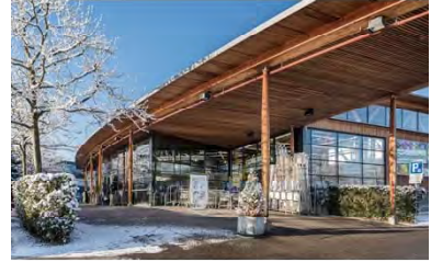
36. Langenthal, Gaswerkstrasse 33c
