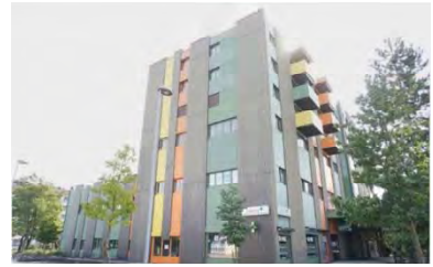
18. Delémont, Rue de l'Avenir 3/5
